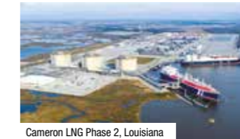
Cameron LNG Phase 2, Louisiana
